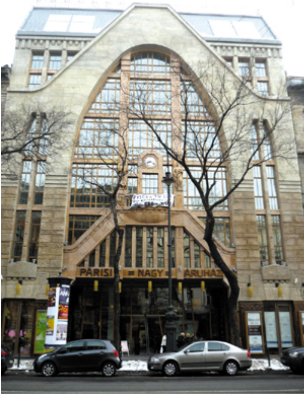
Az Andrássy úti homlokzatot a vasbeton ív uralja
