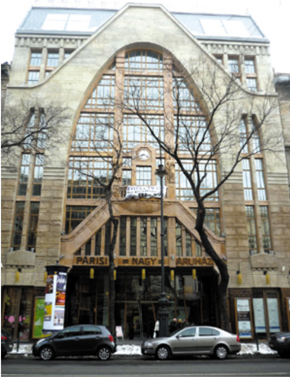
Az Andrásy úti homlokzatot a vasbeton iv sralja
