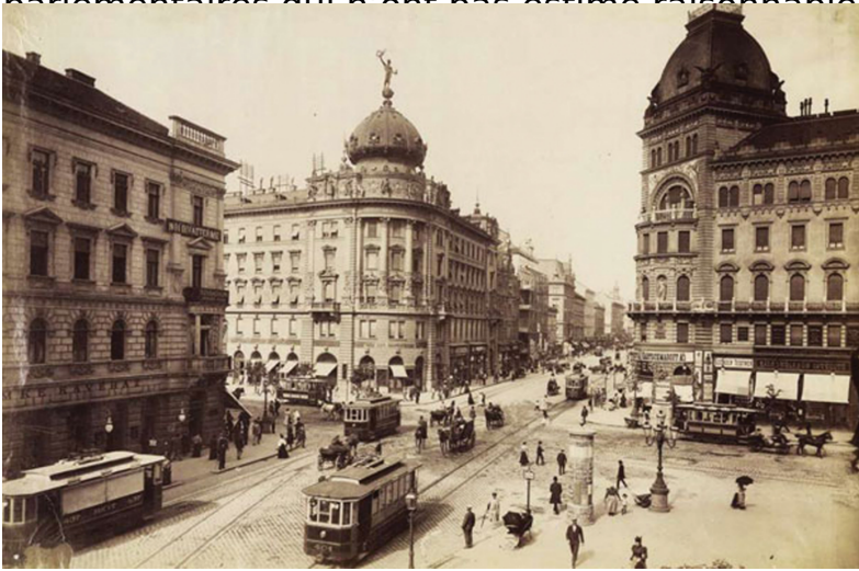
A la place, la construction du Grand
