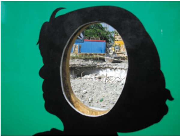
Les grands travaux de la mairie de Budapest
